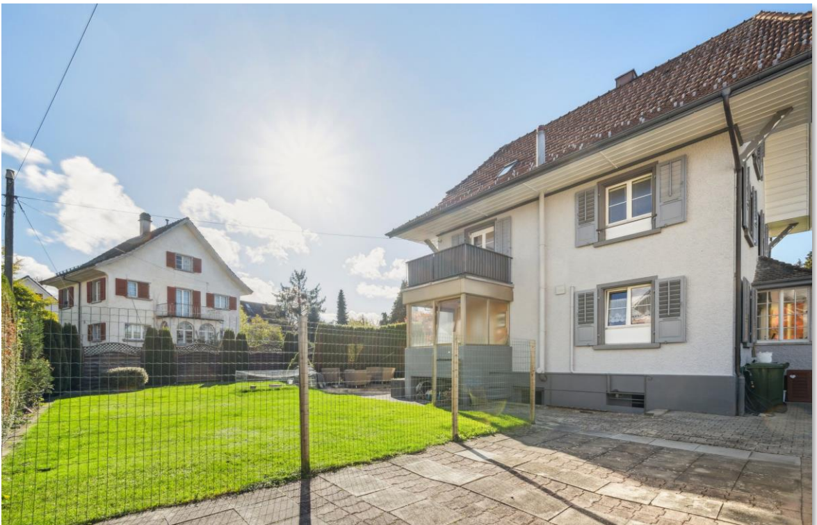
Ansicht Garten / Innenhof
