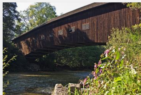
Die längste bedeckte Holzbogenbrücke Europas (Gemeinde Hasle)
